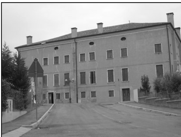
Fig. 11 – Villa Grimani (XVI sec.). Facciata rivolta verso l'interno del paleomeandro (si nota il dislivello dell'argine a fronte).
