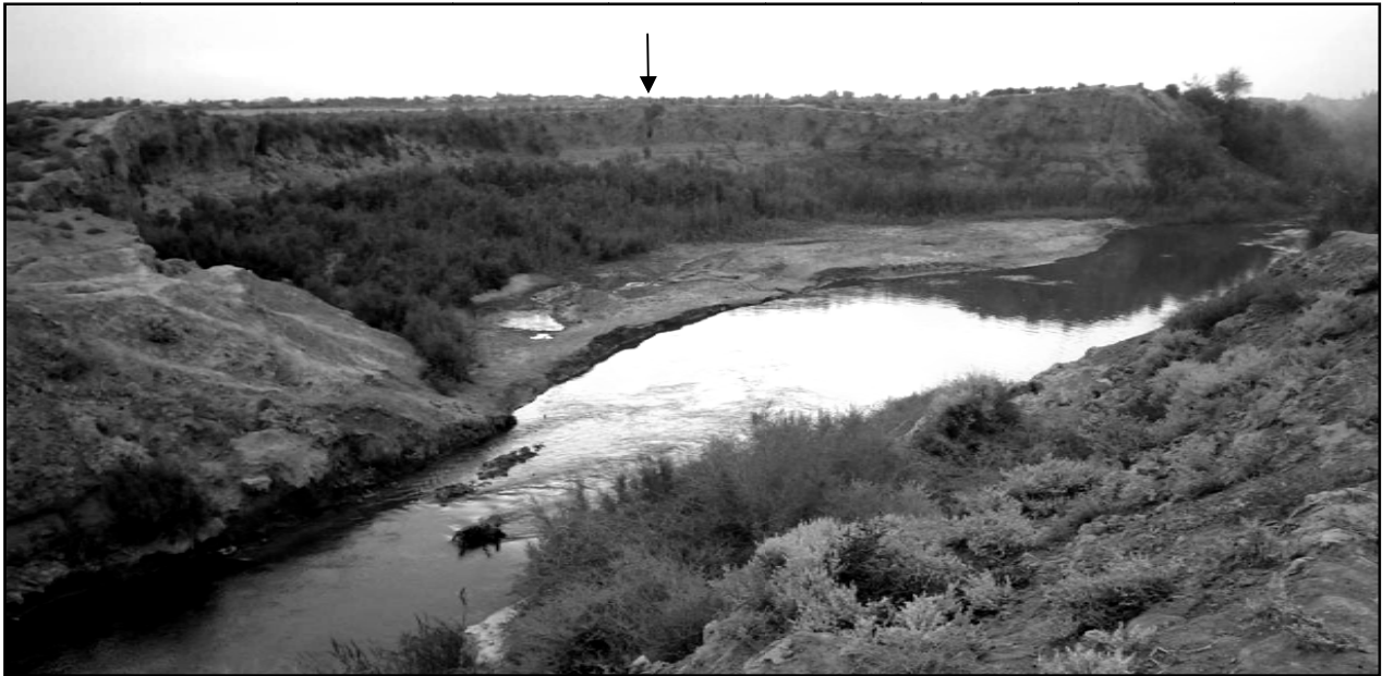
Fig. 13 – Sezione n. 5 sezione del canale, foto d'ambiente, superficie aperta da erosine laterale e scalzamento al piede della sponda.
