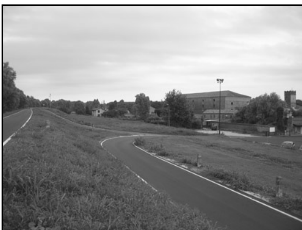
Fig. 12 – Allargamento dell'argine artificiale (banca e sottobanca) del fiume attuale in corrispondenza dell'inserzione del vecchio corso.
